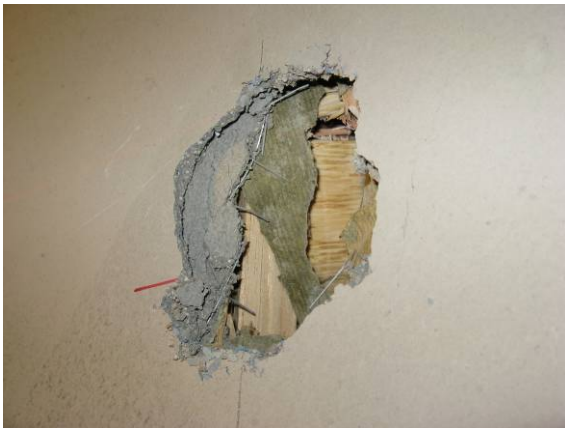
(13) 試験体 No.5, ミサイル D の貫通痕
