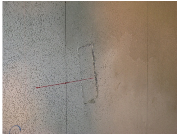
(12) 試験体 No.5, ミサイル C の衝突痕
