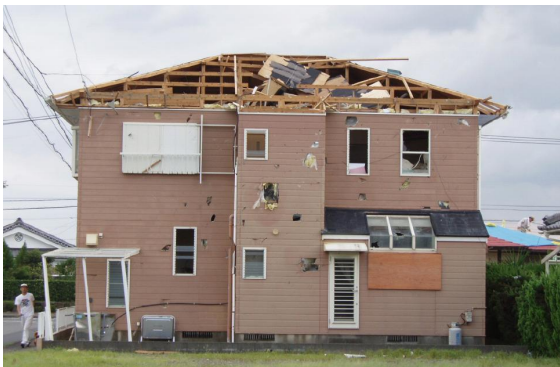
写真 1 台風 0514 での飛来物による被害 (宮崎地方気象台提供)
