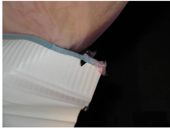
(10) 試験体 No.4, 釘頭抜け
