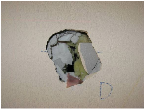
(17) 試験体 No.6, ミサイル D の貫通痕
