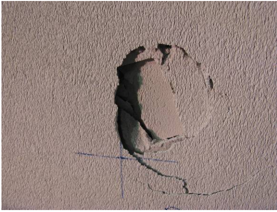
(15) 試験体 No.6, ミサイル B の衝突痕
